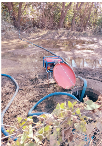
Odpompowywanie wody ze studni w ROD im. A. Mickiewicza w Nysie, Okręg Opolski
