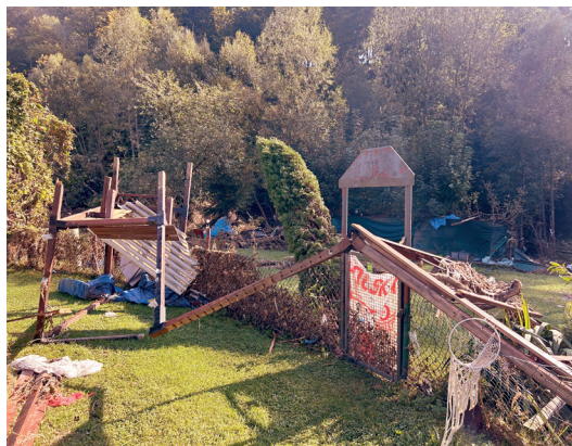
Zniszczone elementy wyposażenia działki w ROD „Zgoda” w Bystrzycy Kłodzkiej, Okręg Sudecki
