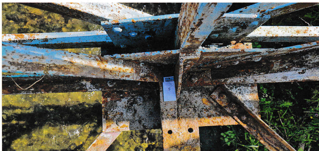
Zdj 10: Widok węzła
