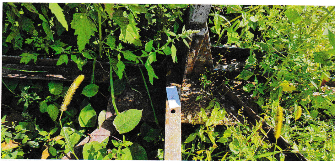
Zdj 6: Widok węzła
