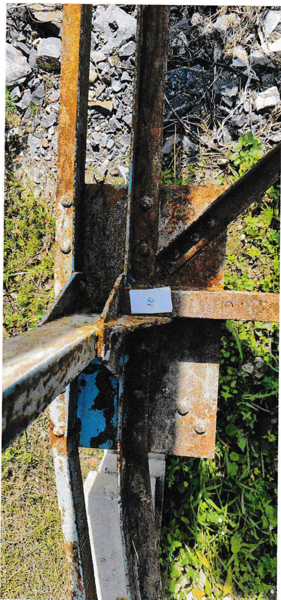
Zdj 17: Widok węzła
