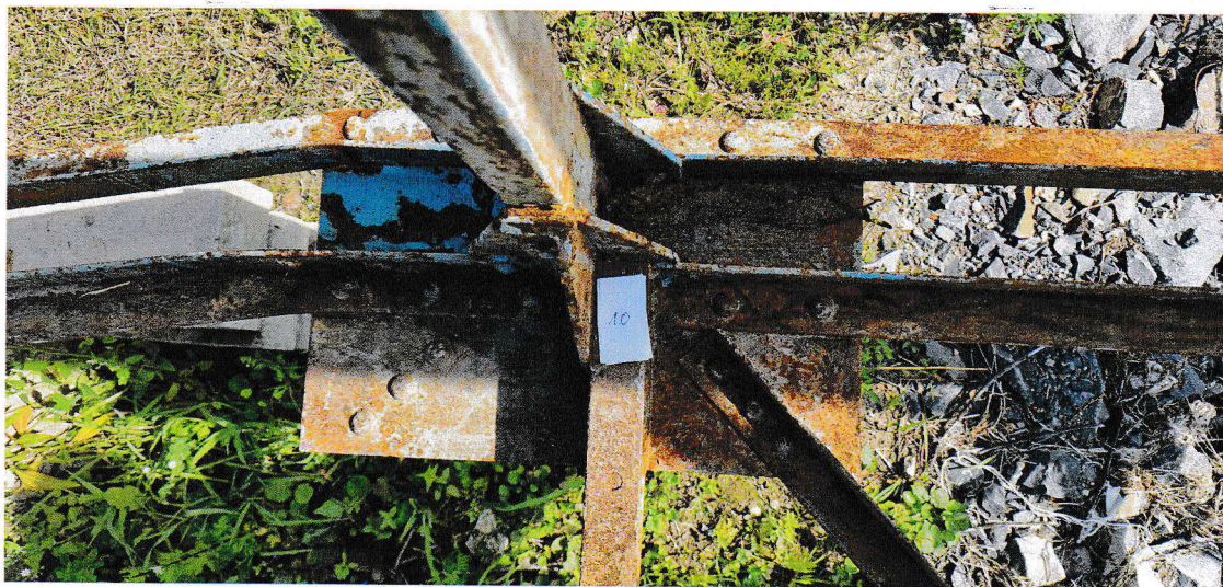
Zdj 15: Widok węzła
