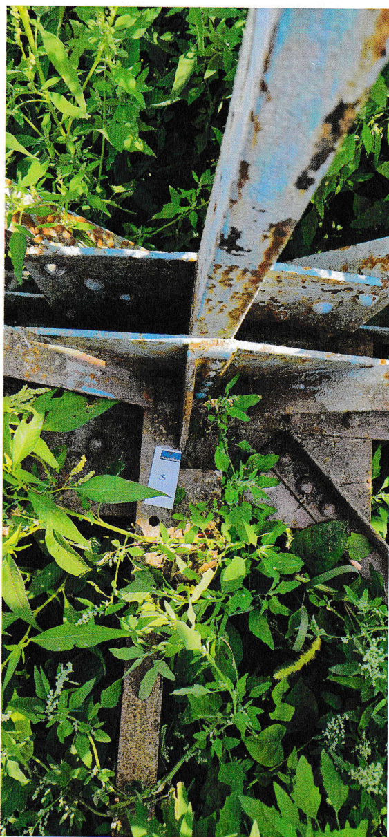
Zdj 7: Widok węzła
