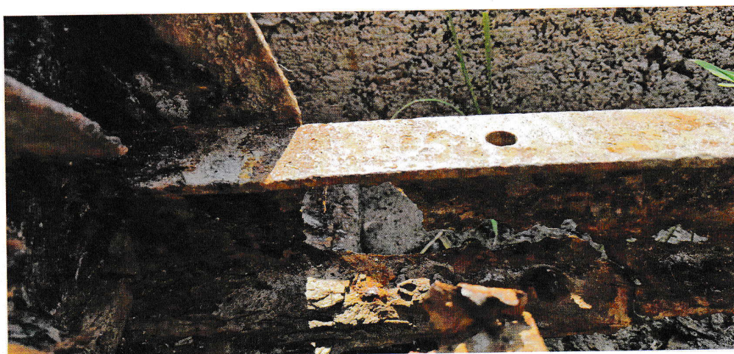
Zdj 5: Zbliżenie na poprzecznice podporową
