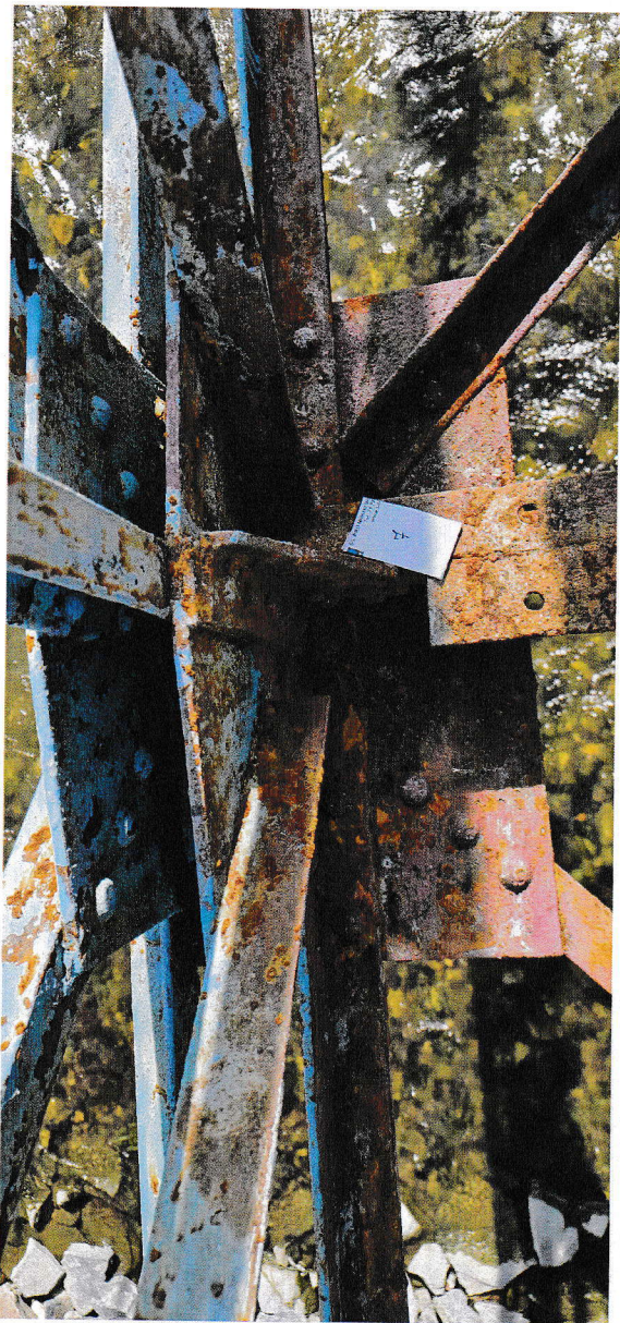
Zdj 12: Widok węzła
