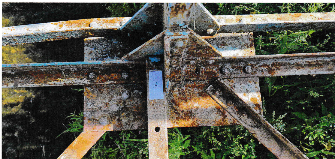
Zdj 9: Widok węzła
