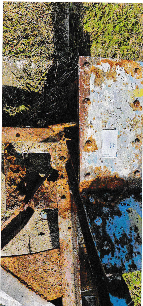
Zdj 19: Widok węzła
