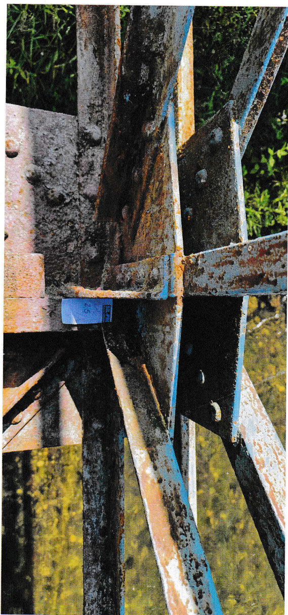
Zdj 33: Widok węzła
