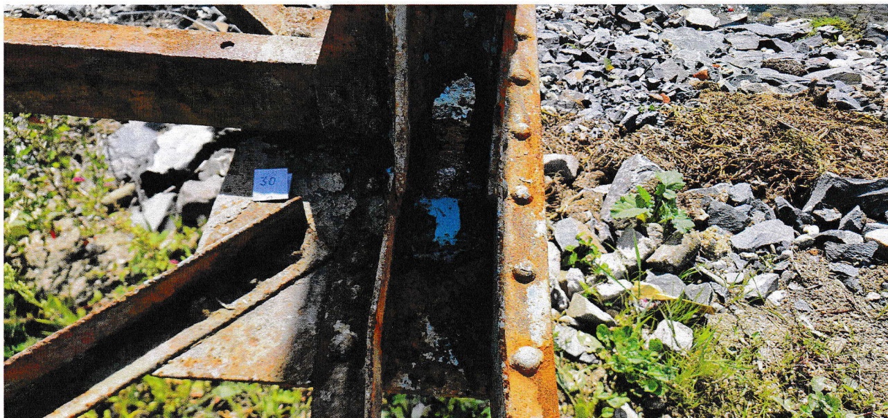
Zdj 23: Widok węzła
