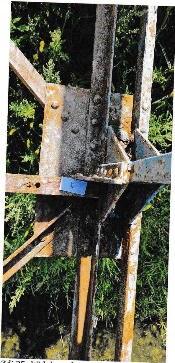
Zdj 35: Widok węzła
