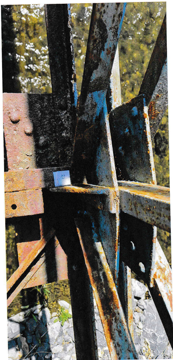
Zdj 29: Widok węzła
