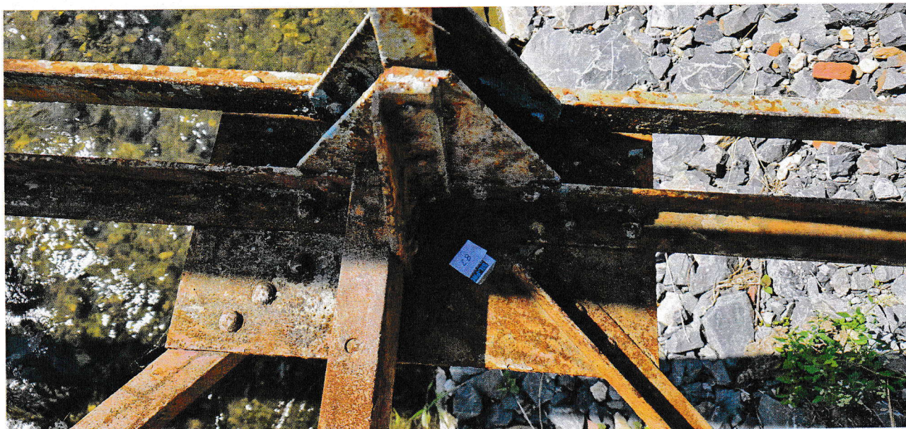
Zdj 27: Widok węzła
