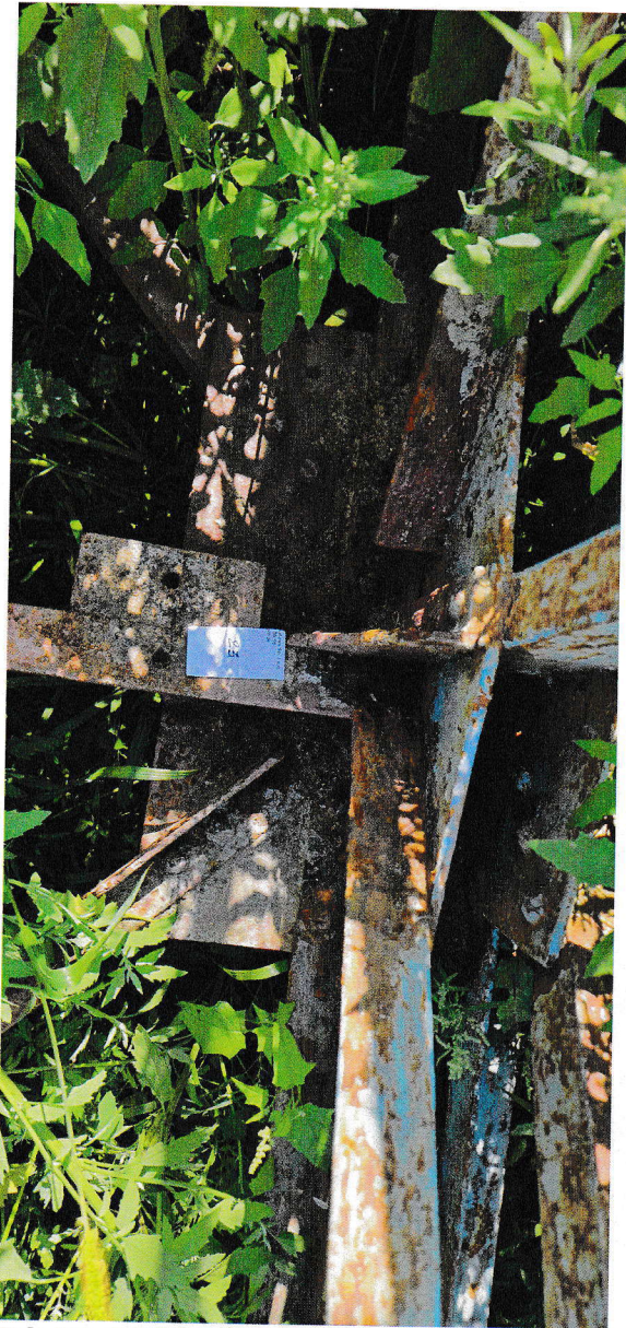
Zdj 37: Widok węzła
