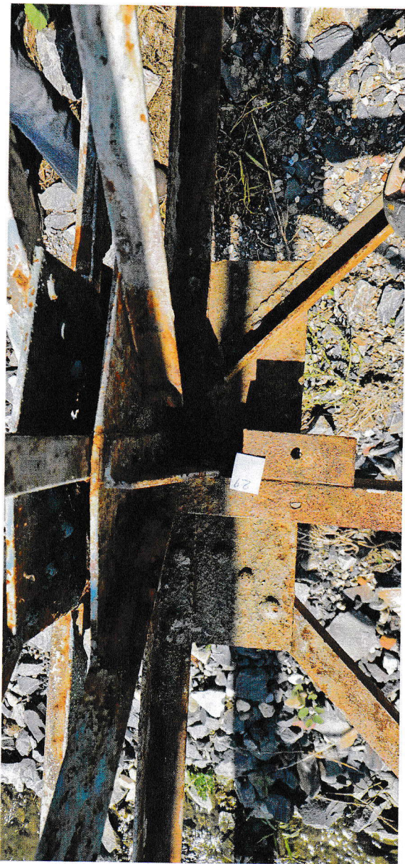
Zdj 25: Widok węzła
