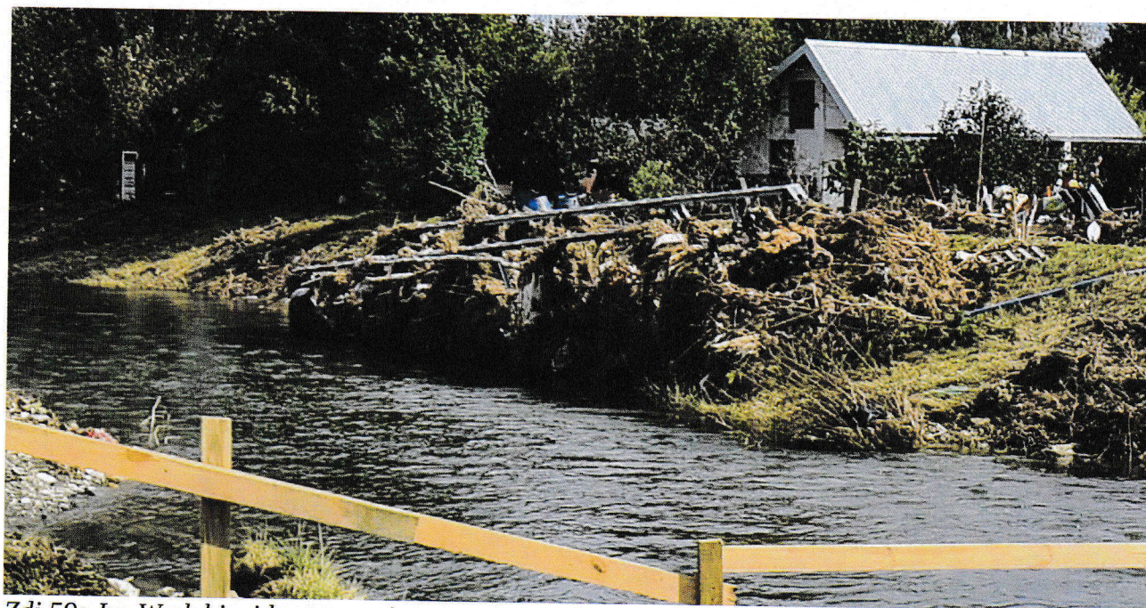
Zdj 59: Jw. W głębi widoczna zanieczyszczona stalowa konstrukcja kładki wyrzucona na brzeg
