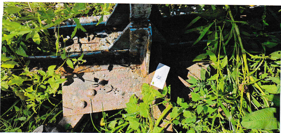
Zdj 40: Widok węzła
